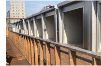
▲検査センター
